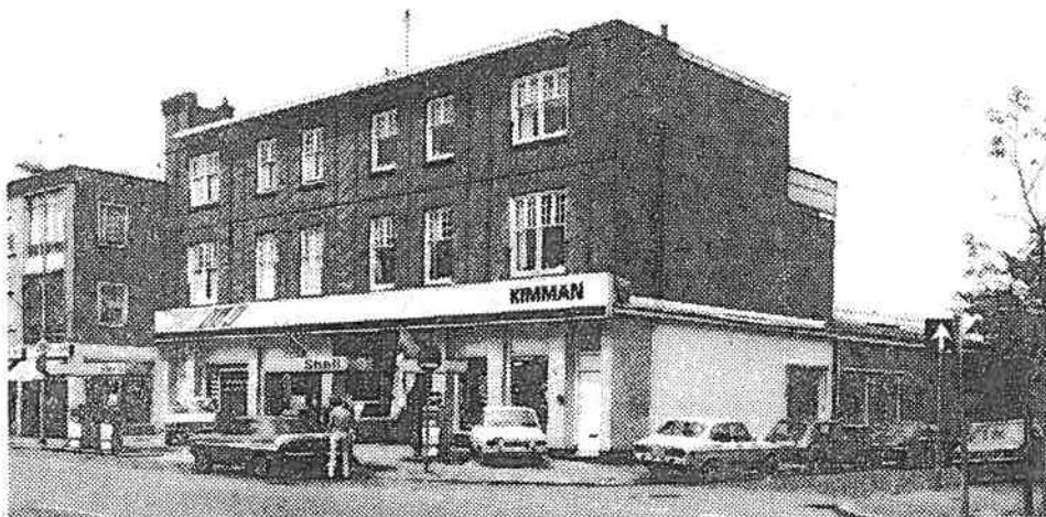
☆ Het garagebedrijf Kimman op de hoek van de Zijlweg en de Prévinairestraat. Dit gebouw moet worden afgebroken.
